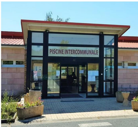
La piscine est fermée depuis un mois et des expertises sont en cours. Photo Stéphanie Paquet
